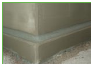
Przygotowanie podłoża
