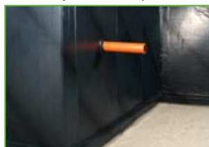
Gotowa hydroizolacja
